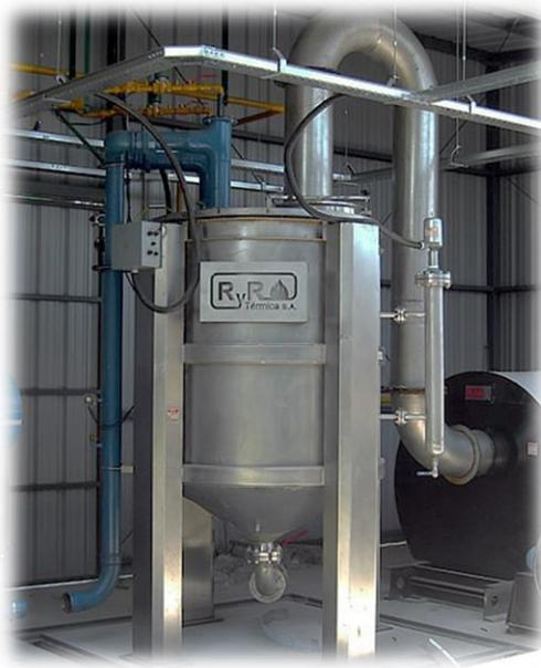
*Figura 4.06 - Concentrador de efluentes R&R*
